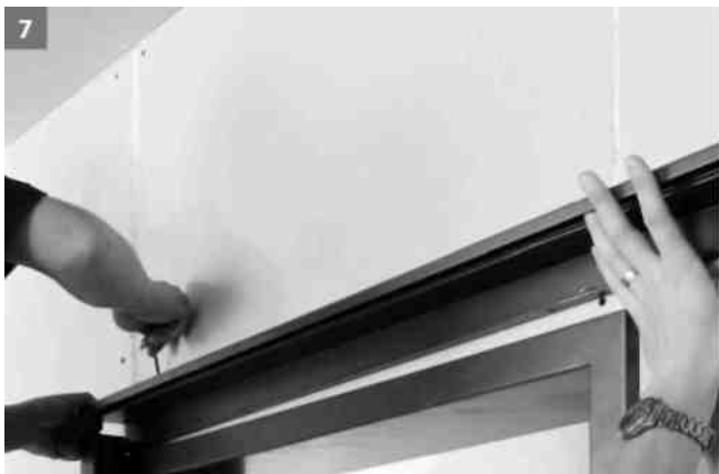
7 Vyšroubujte šrouby ze zárubně a umístěte nosný profil kolejnice na zárubeň
