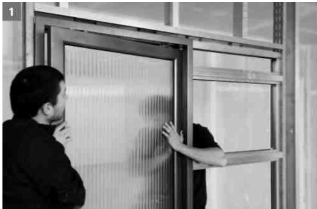
Posuvné dveře vložte do zárubně.
