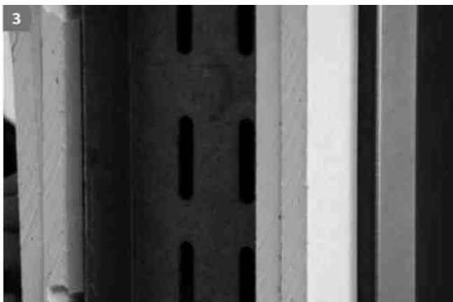
3 Na obou stranách srovnáte pomocí vodováhy...
