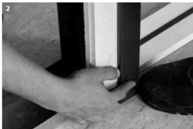
2 Vymezte prostor pro opláštění mezi lemem zárubně a UA - profilem pomocí pásků sádkartonu.
