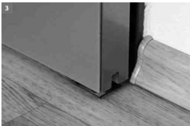
Podlahové vedení při variantě před zdi jdoucí.
