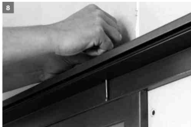
8 Nosný profil sešroubujte se zárubní, v místě CW profilů SDK příčky vyvrtejte do nosného profilu otvory pr. 4mm a nosný profil přišroubujte k CW profilům příčky.
