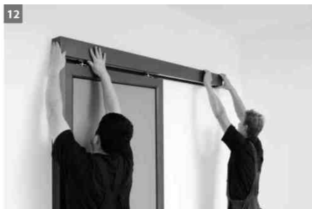
12 Po montáži dveří (kapitola 7) nasadte kryt kolejnice.
