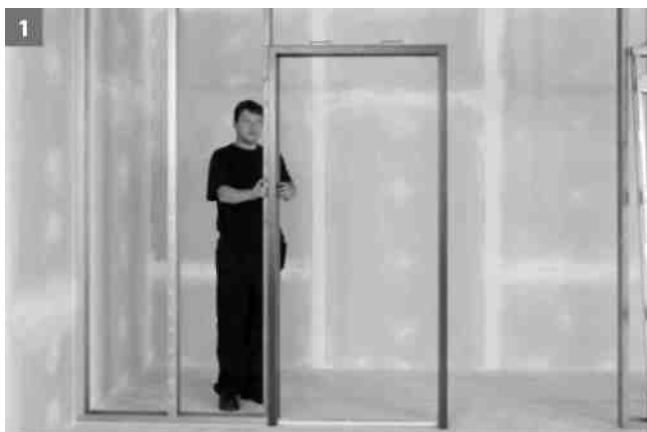
1 Zárubeň svisle srovnáte s UA - profilem (tloušťka plechu 2 mm). (Zobrazena pravá zárubeň)
