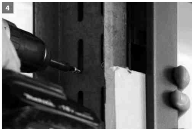
4 ...a přišroubujte. UA - profil přišroubujte vhodnými šrouby (samořezné šrouby min. velikost 4,8) ke kotvám zárubně. Ke každé kotvě 2 šrouby.
