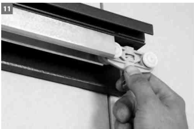
11 Do lišty vložte obě vodící kladky a koncový doraz.
