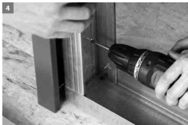
4 Příčka ze sádrokartonu musí být zesílena UA - profilem.
