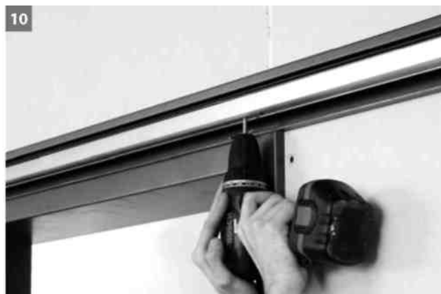
10 Vodicí kolejnici přišroubujte k nosnému profilu.
