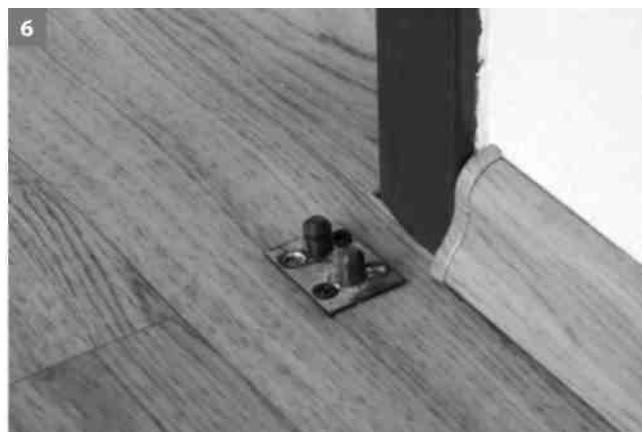
6 Namontujte vodící čepy dveří na hotovou podlahu, pozor soklová lišta nesmí bránit otevírání dveří.
