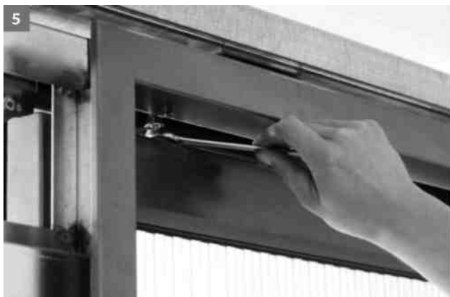
Výškové nastavení křídla zajistěte kontra-maticí M8. (stranovým klíčem velikost 13)
