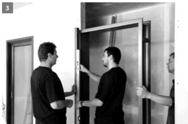
3 Zárubeň se osadí do otvoru, vyrovná a odpovídajícím způsobem ukotví
