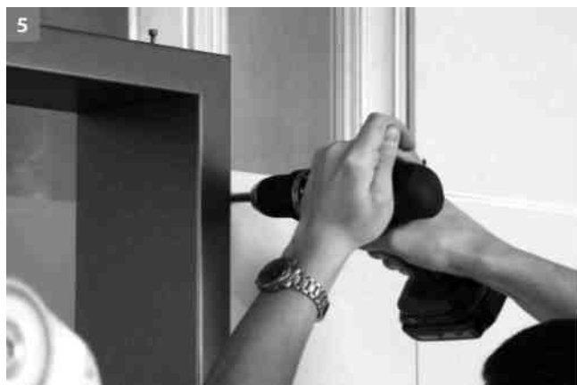
5 Montáž zárubně ukončete opláštěním příčky.
