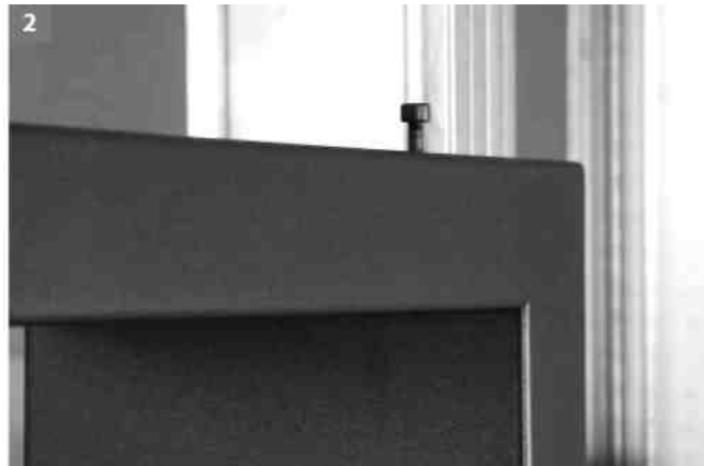
2 Šrouby pro nosný profil vodící kolejnice jsou našroubovány v zárubni, směr otevírání je pevně stanoven z výroby!
